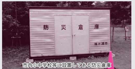
市内小中学校等に設置してある防災倉庫
